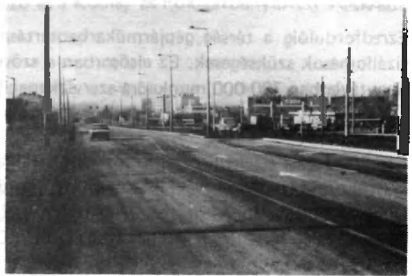
A 7. sz. főút új átkelési szakasza az ÁFOR üzem- anyagtöltőállomással
