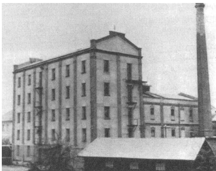
A csáktornyai malom és villanytelep, 1903. Kalsan, 157. oldal.
