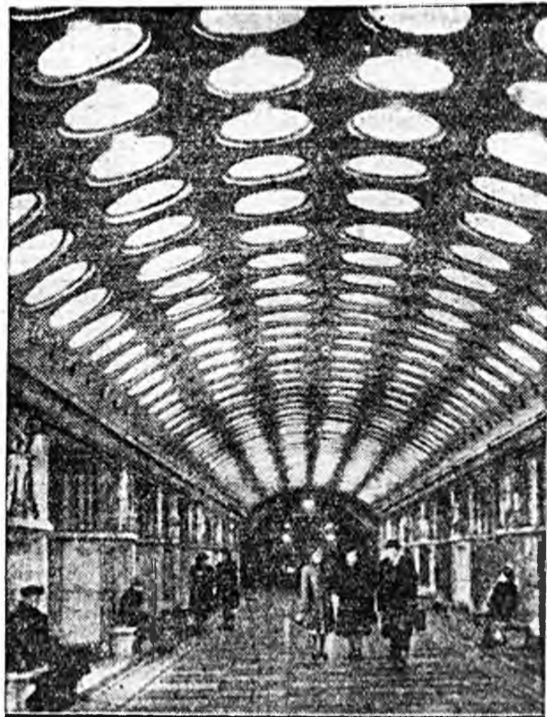
Az „Elektróvezényelők” (Világgyári) Állomás Moszkva újjárendezett ipari negyedében. Az állomást a sztahané öt éves terv keretében építették fel.
