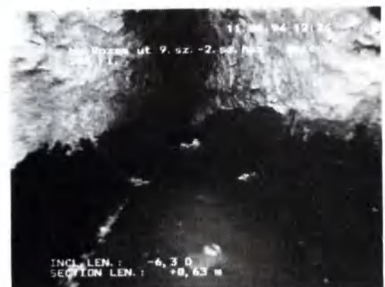
Nem cseppkőbarlang. Zsradékok kicsapódása a csatornafalon.
