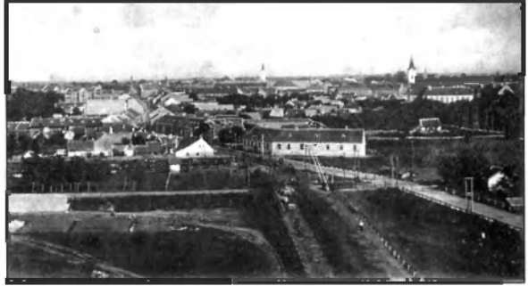
Vasúti átjáró Kiskanizsa felől
